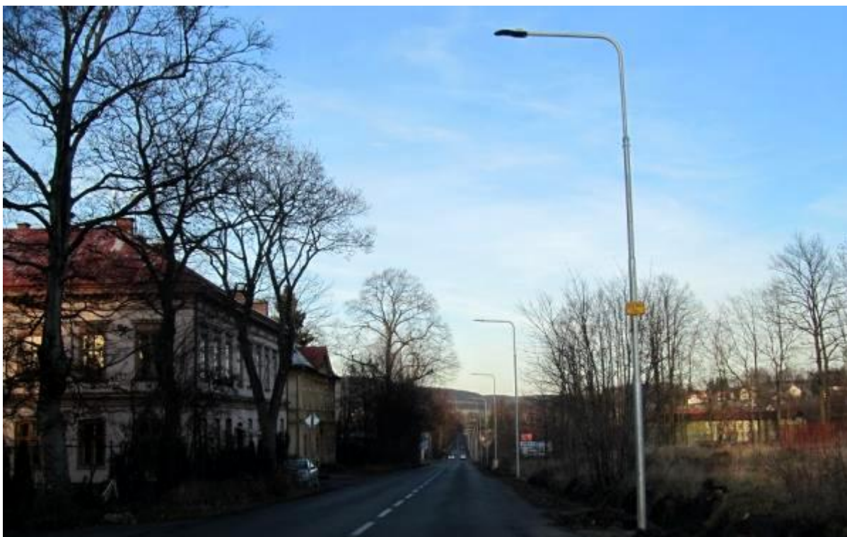
Nové osvětlení na ulici Plzeňská
