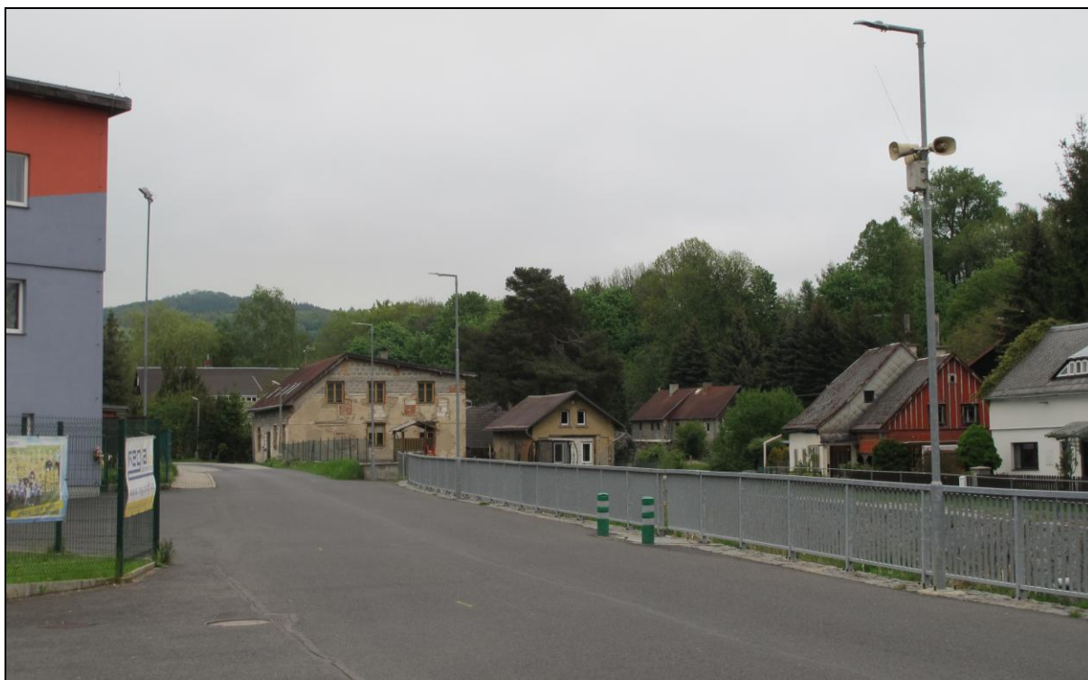
Sloupy veřejného osvětlení – ul. Moravská
